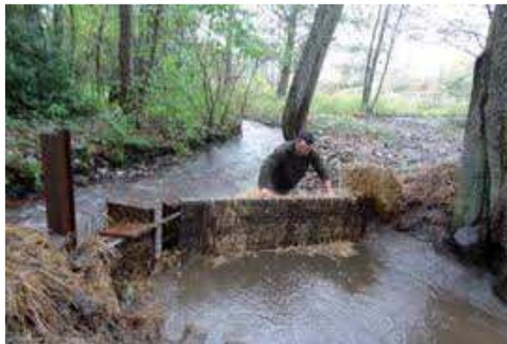
*Figure 15 : Mise en place d'un filtre à paille*
